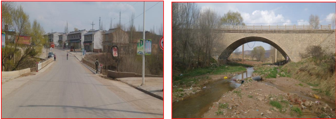
图 1-2 北河桥现状照片
