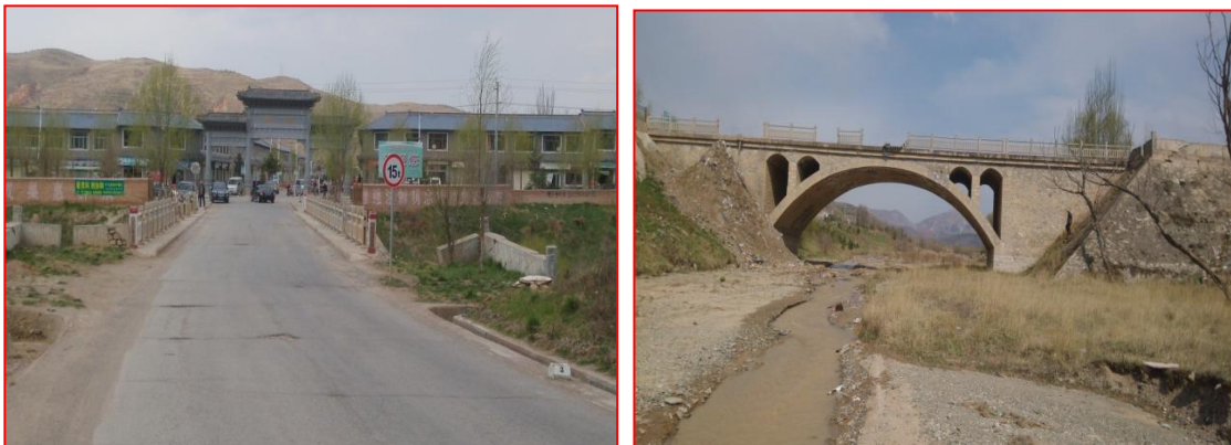
图 1-1 南河桥现状照片
