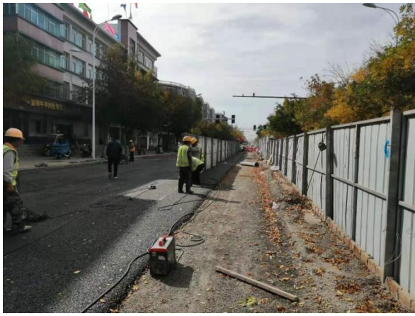
施工场地围挡
