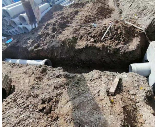
雨污分流管道开挖及铺设
