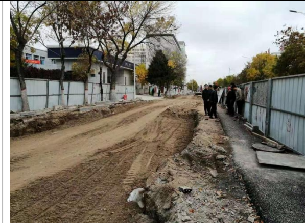
地面平整恢复
