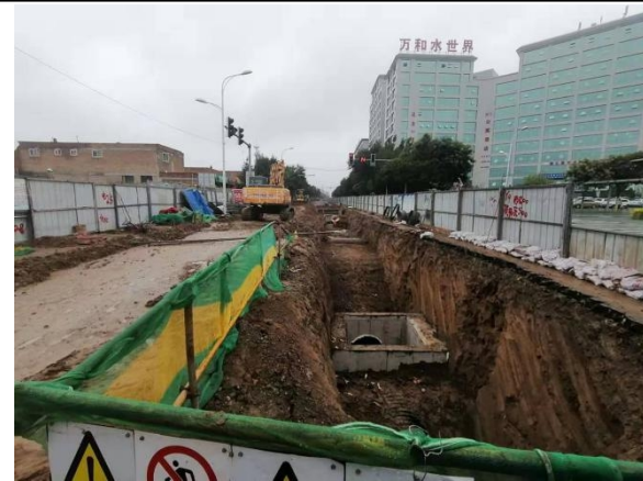
雨污管道铺设
