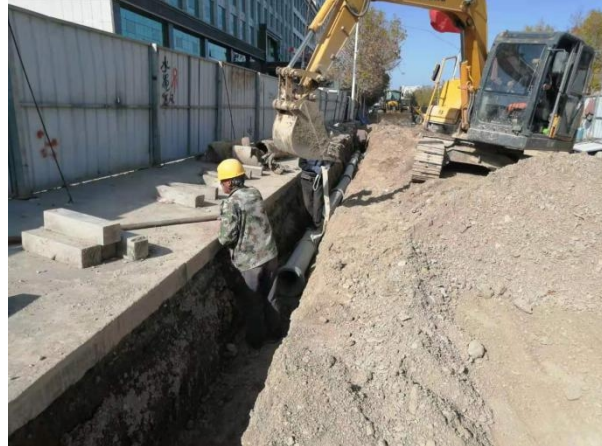
管道开挖及施工区域设置围挡
