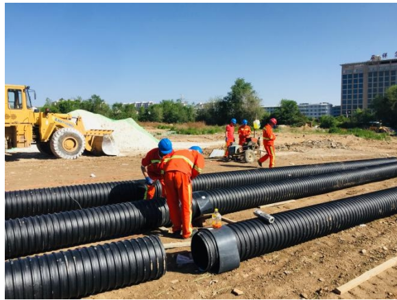
管道连接铺设
