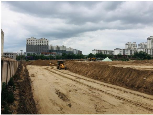
平整施工场地
