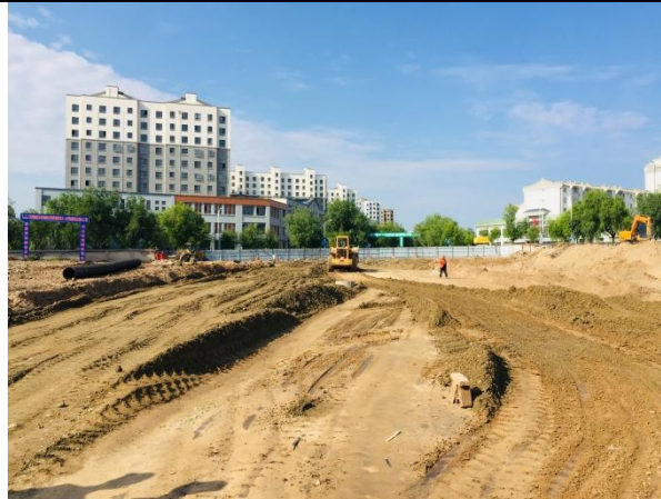
施工区域设置围挡
