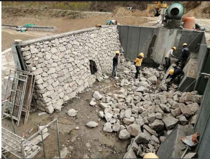
河道边坡用石头铺设
