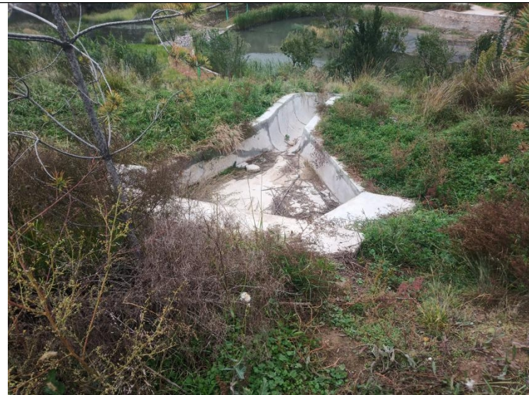
灌溉系统恢复工程
