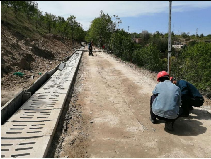
雨水收集槽建设
