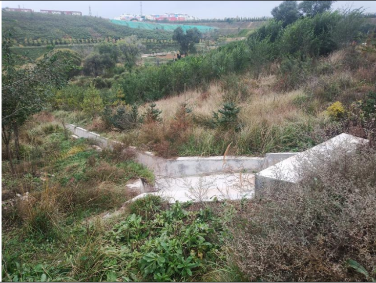
灌溉系统恢复工程
