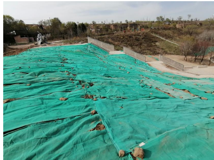
施工场地篷布遮盖
