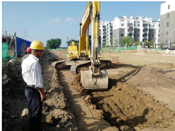
道路平整期围挡及篷布遮盖
