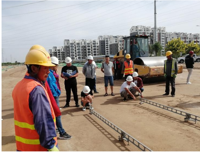
管道施工现场
