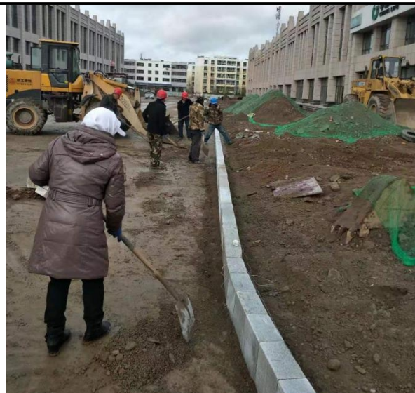
路牙铺设，物料遮盖篷布
