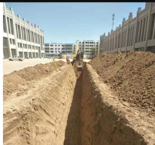
水管开挖及路面指示路线
