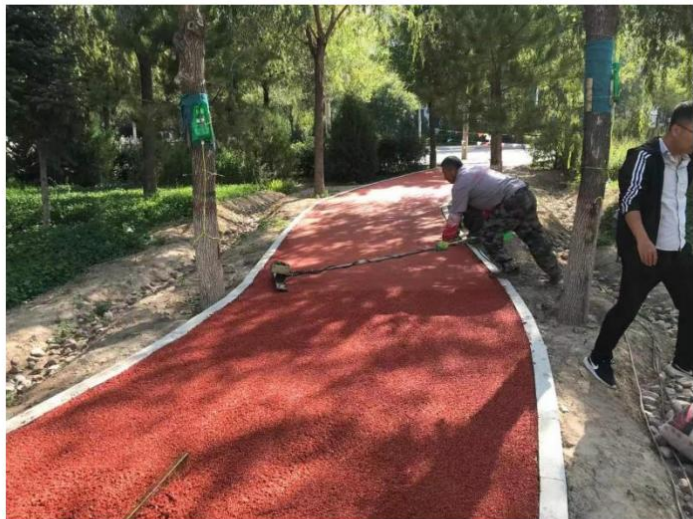
公园橡胶道路铺设
