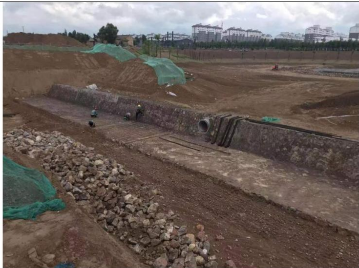
集水池及集水管道建设
