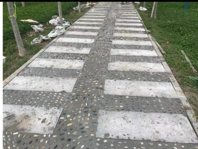
公园道路铺装
