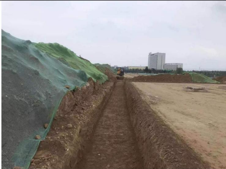
集水沟建设及裸露物料遮盖防风抑尘网
