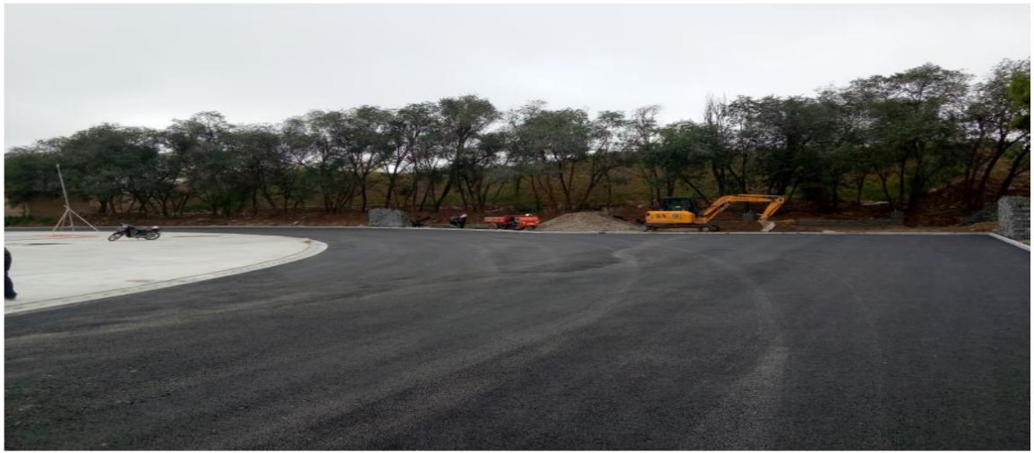
操场施工期照片
