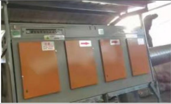
生物除臭+UV 光解+活性炭吸附装置及风机
