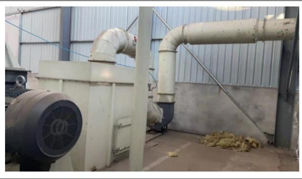
生物除臭+UV 光解+活性炭吸附装置及风机
