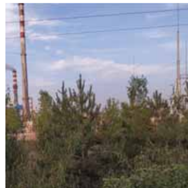
图8 本项目线路终点(金昱元二期 110kV 变电站)
