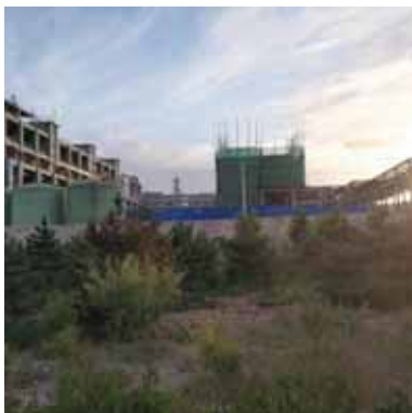
图7 金昱元在建厂区
